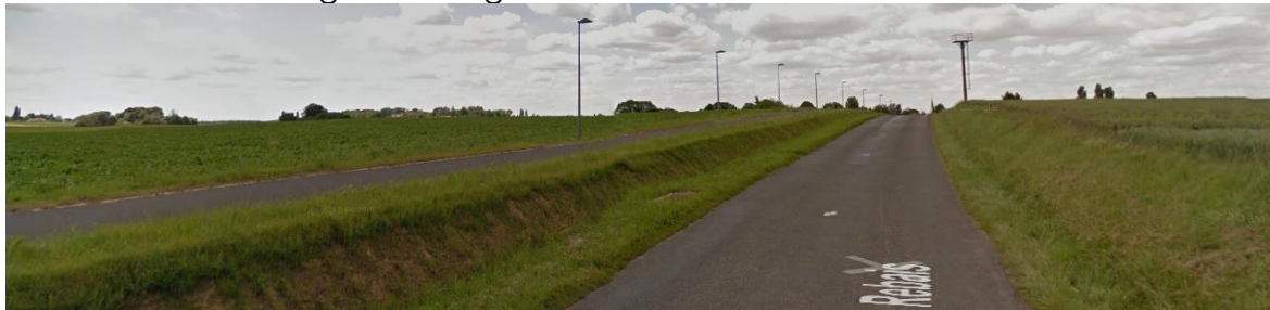
La RD 14 reliant le centre bourg de JOUARRE au village de ROMENY bordée par une liaison douce éclairée.
